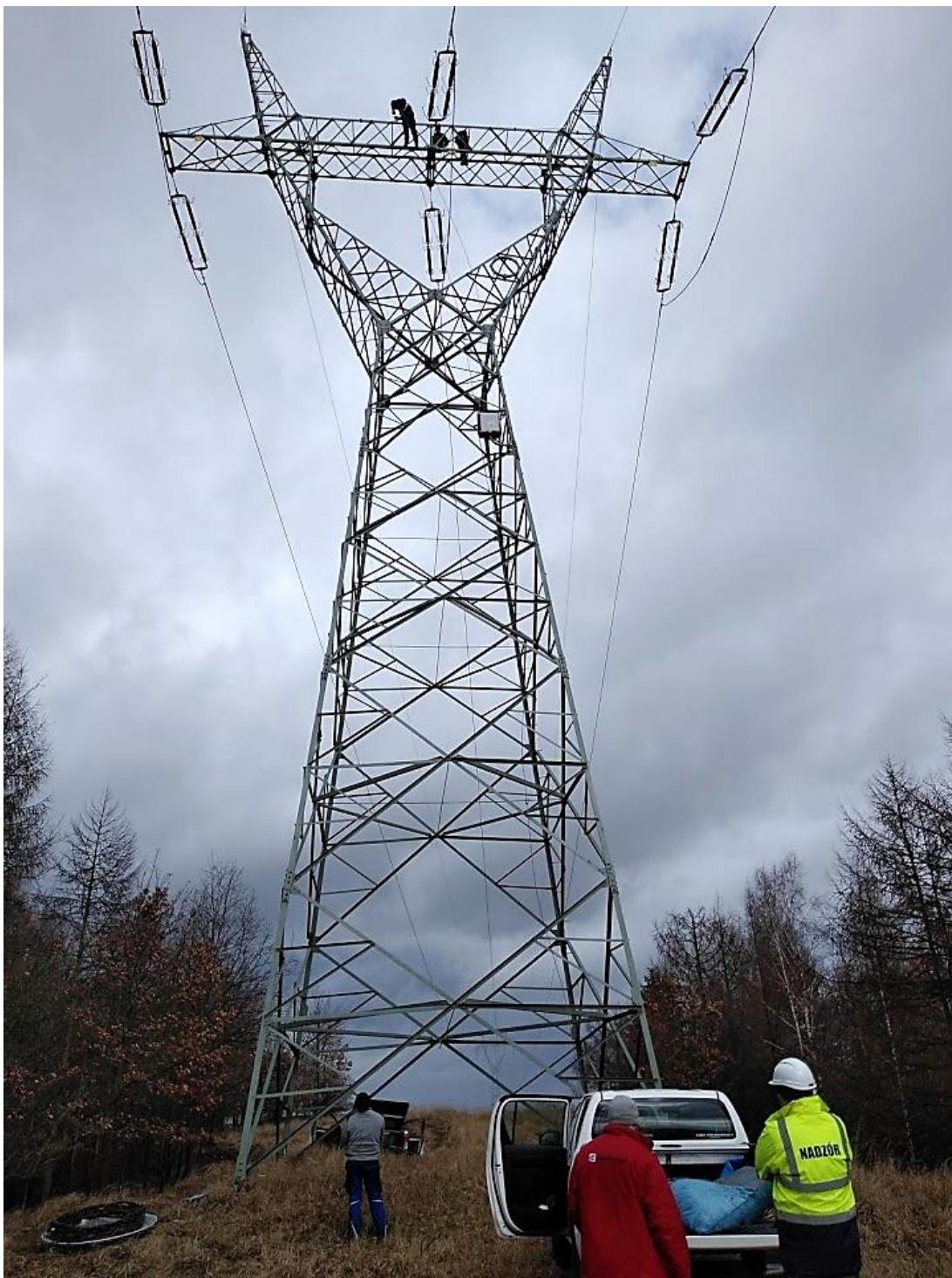
Rys. 15. Przygotowania do montażu platformy na słupie wysokiego napięcia relacji Krajnik – Glinki (źródło: opracowanie własne)
