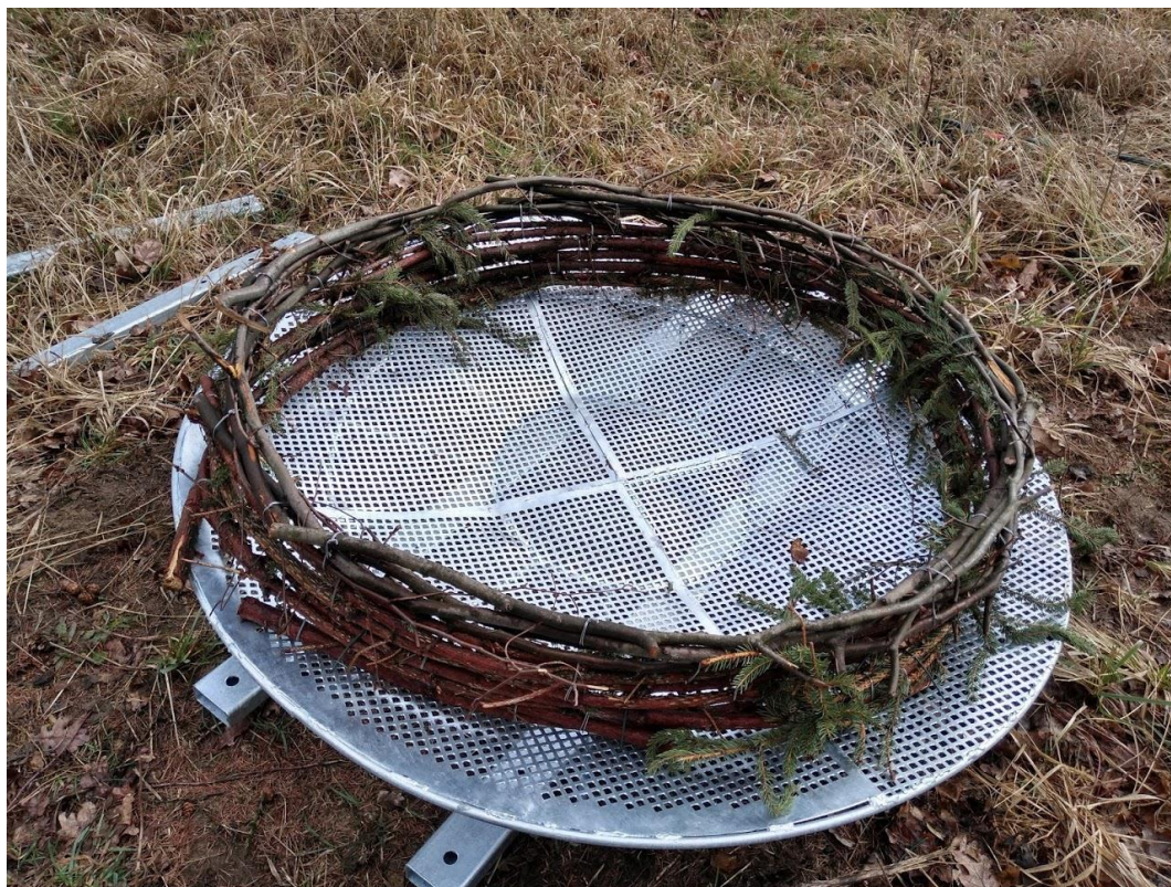
Rys. 16. Wieniec gniazda na platformie tuż przed montażem na słupie wysokiego napięcia (źródło: opracowanie własne)
