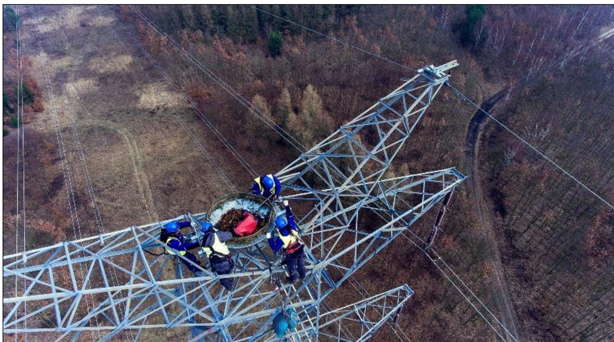
Montaż platformy lęgowej na słupie 400 kv linii PSE Fot. Archiwum DGLP
